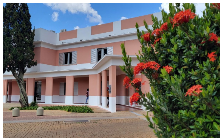
Estão finalizados os reparos do Centro Cultural Marietta Telles e da Secretaria de Estado de Desenvolvimento Social
